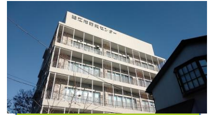
狛江市防災センター (市役所隣接で耐震建物)
