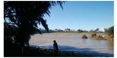
2019/10/12、台風直後の 二子多摩川の氾濫状況
